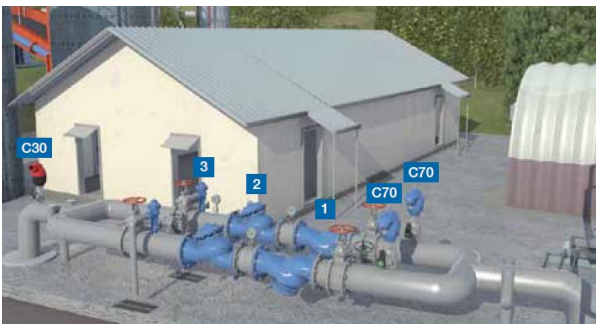
Image 4.3 - Système de réduction de pression à redondance complète
