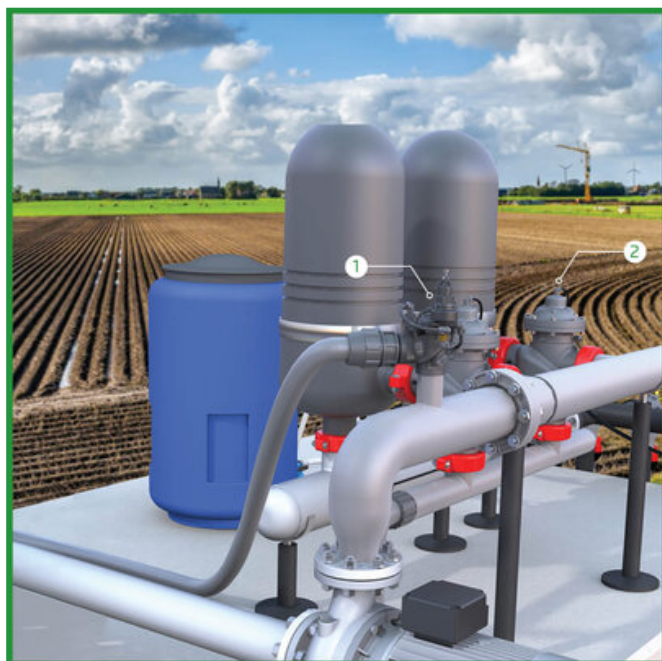
[1] Le Modèle IR-23Q-2W de BERMAD protège le système contre les pics de pression.
