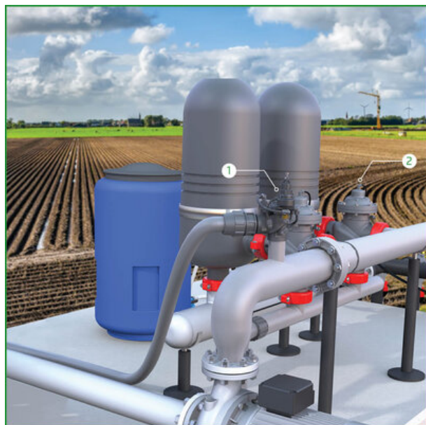
[1] BERMAD IR-23Q-2W 型号可保护系统免受压力冲击。 [2] IR-350 型过滤反冲洗水力控制阀
