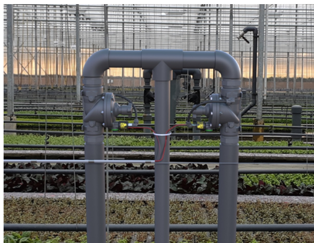
[1] BERMAD型号IR-21T-N5-2W-M根据电信号的响应实现严密关闭和开启，该信号控制电磁阀开启或关闭阀门的内部液压回路。
