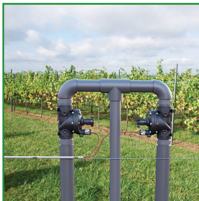
[1] דגם IR-21T של ברמד נפתח ונסגר באופן אוטומטי בתגובה לאות חשמלי, שגורם לסולנואיד לפתוח או לסגור את לולאת ההידראוליקה הפנימית של המגוף.
