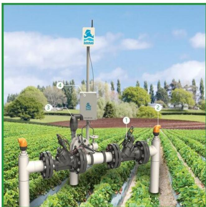
[1] Le modèle IR-12T-LS-55-3W-X de BERMAD établit une zone de pression réduite, protégeant les lignes latérales et la ligne de distribution.
