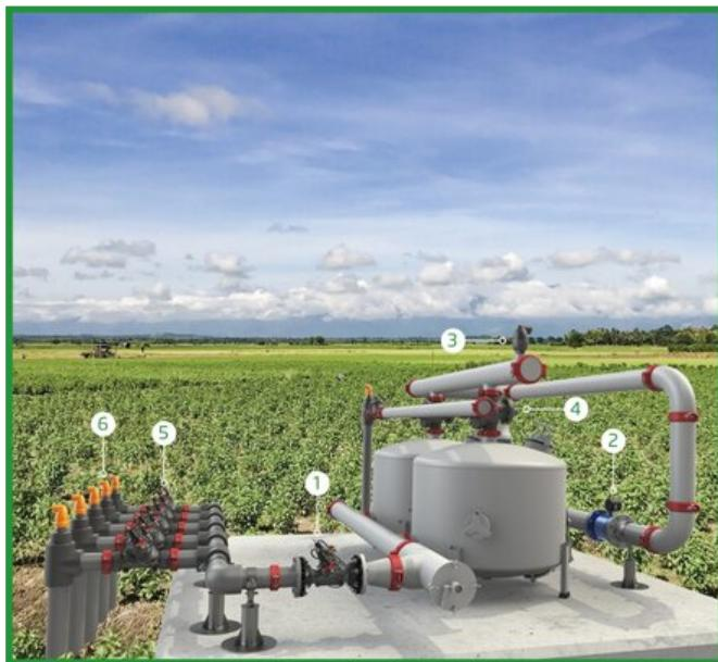
[1] Il modello BERMAD IR-123-3W-XZ mantiene la pressione del sistema di alimentazione e stabilisce una zona di pressione più alta ridotta.
