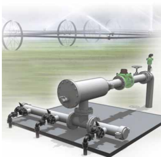
[1] BERMAD IR-120-55-2W 型号在接收到电信号后开启，建立减压区。
