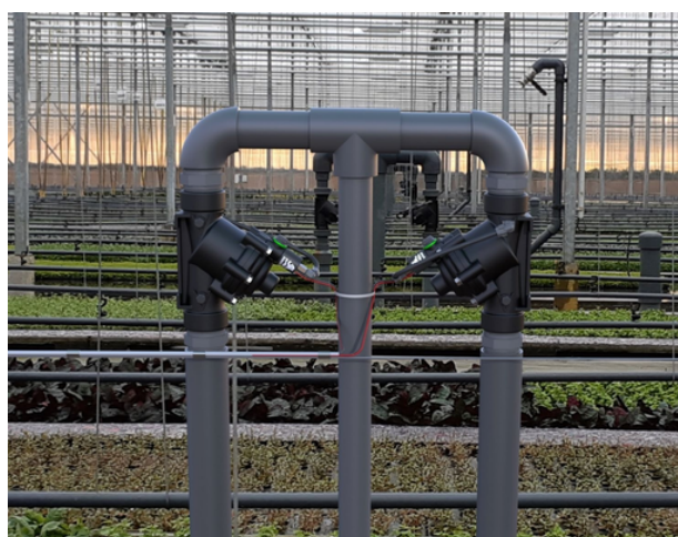
[1] Il Modello BERMAD IR-11T-N5-2W si apre e si chiude a tenuta stagna in risposta a un segnale elettrico, che induce il solenoide ad aprire o chiudere il circuito idraulico interno della valvol
