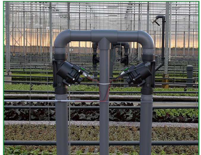
[1] דגם BERMAD IR-11T-N5-2W נפתח ונסגר באטימה מלאה בתגובה לאות חשמלי, שגורם לסולנואיד לפתוח או לסגור את לולאת הפיקוד ההידראולית הפנימית של המגוף.
