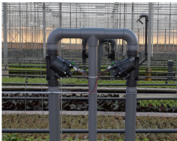
[1] El modelo IR-11T-N5-2W de BERMAD se abre y cierra herméticamente en respuesta a una señal eléctrica, lo que hace que el solenoide abra o cierre el circuito hidráulico interno de la válvula.
