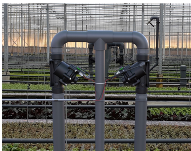
[1] BERMAD 型号 IR-11T-N5-2W 能根据电信号实现严密关闭和开启，电信号驱动电磁阀开启或关闭阀门的内部液压回路。
