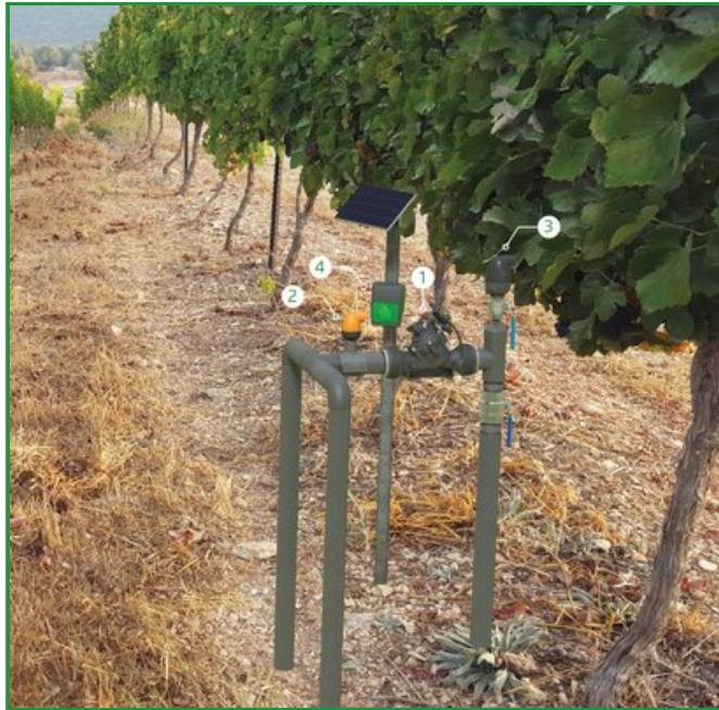
[1] Le Modèle IR-110-3W-X de BERMAD s'ouvre en réponse vers un signal électrique.
