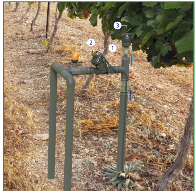
[1] דגם ברמד IR-100-DC-Z נפתח לפי פקודה ידנית מקומית. [2] שסתום אוויר קינטי דגם IR-K10 [3] שסתום אוויר משולב דגם IR-C10
